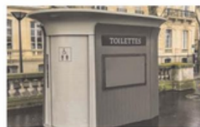
Het openbaar toilet / latrine
